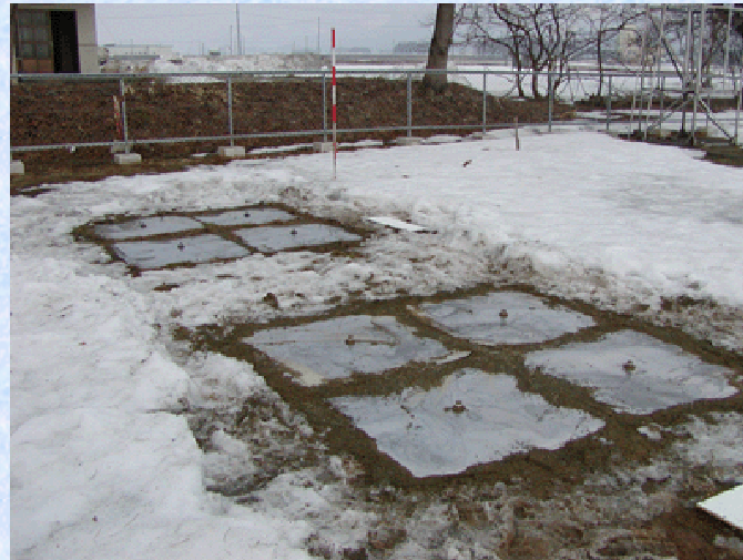
設置状況写真（‘03年3月26日）
