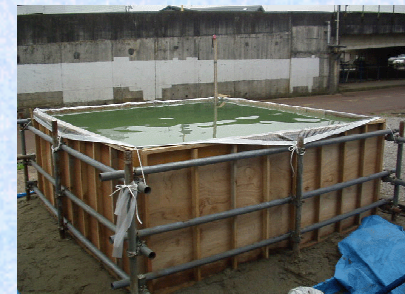
ビニール製水槽をはり、その中に水を入れる。
