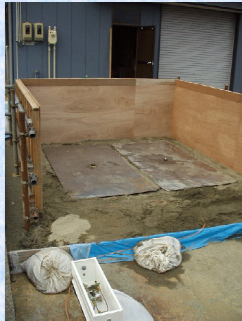
メタルウェファアを木枠内に設置する。
